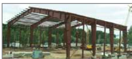
Рис. 10. Монтаж конструкций рам
