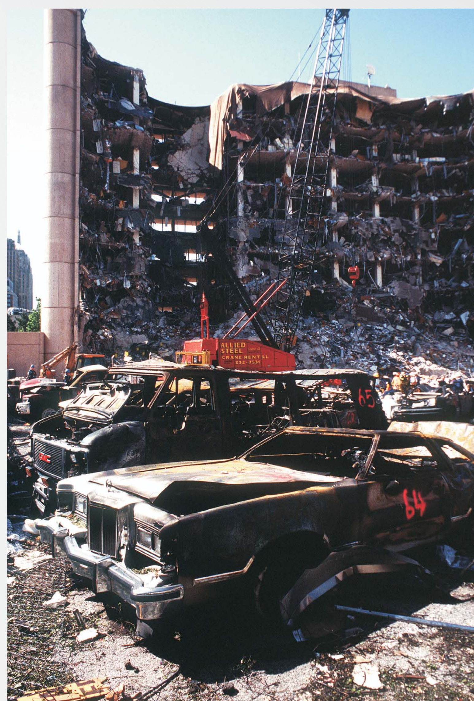
РИС. 5 ВЫСОТНОЕ ЗДАНИЕ В ОКЛАХОМА СИТИ
