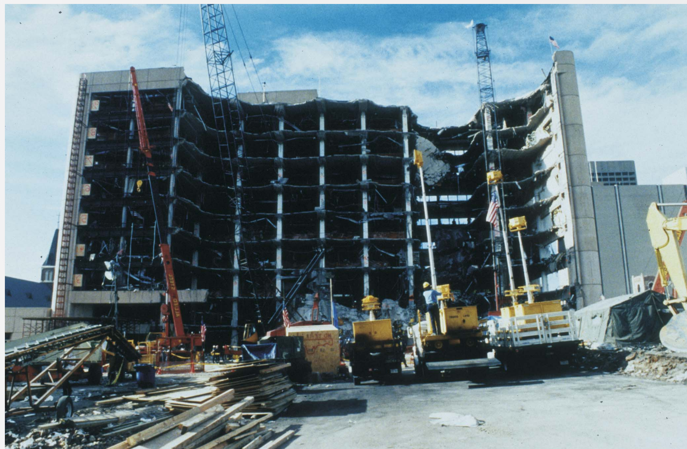
РИС. 2 ВЫСОТНОЕ ЗДАНИЕ В ОКЛАХОМА СИТИ
