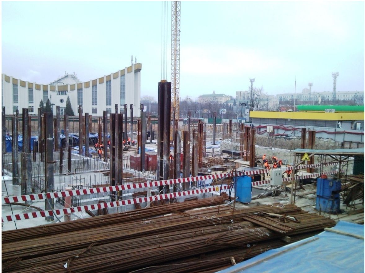
Рис. 1.2 Будівництво багатофункціонального комплексу «Sky towers»
