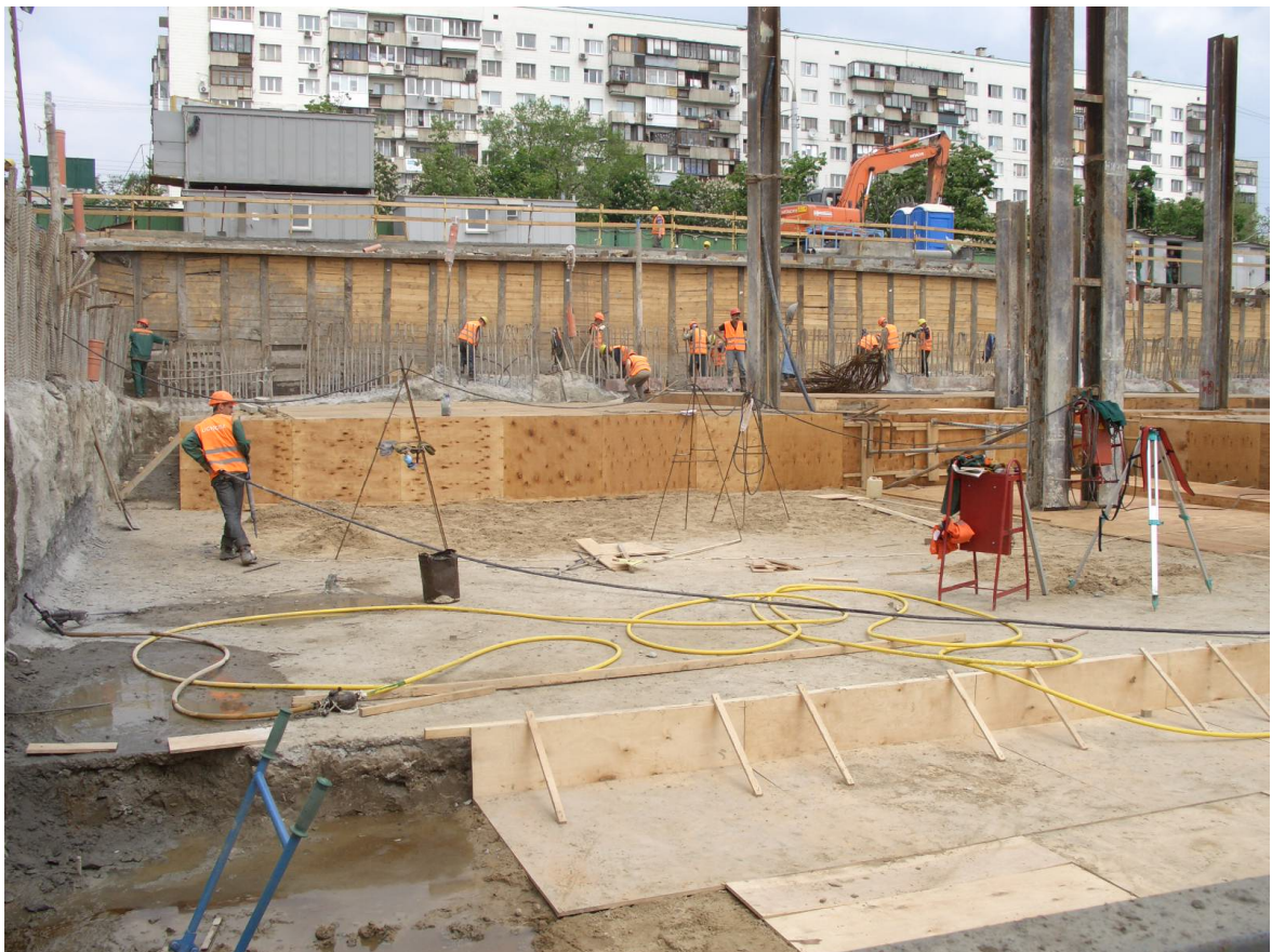
Рис. 1.1 Будівництво багатофункціонального комплексу «Sky towers»
