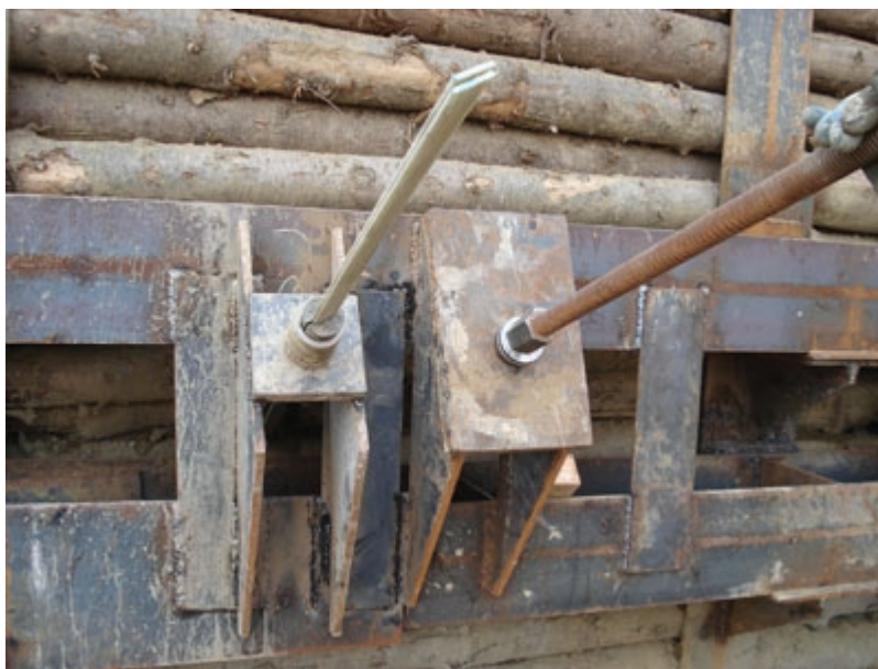
Рисунок 1.1.9. Крепление грунтового анкера к обвязке
