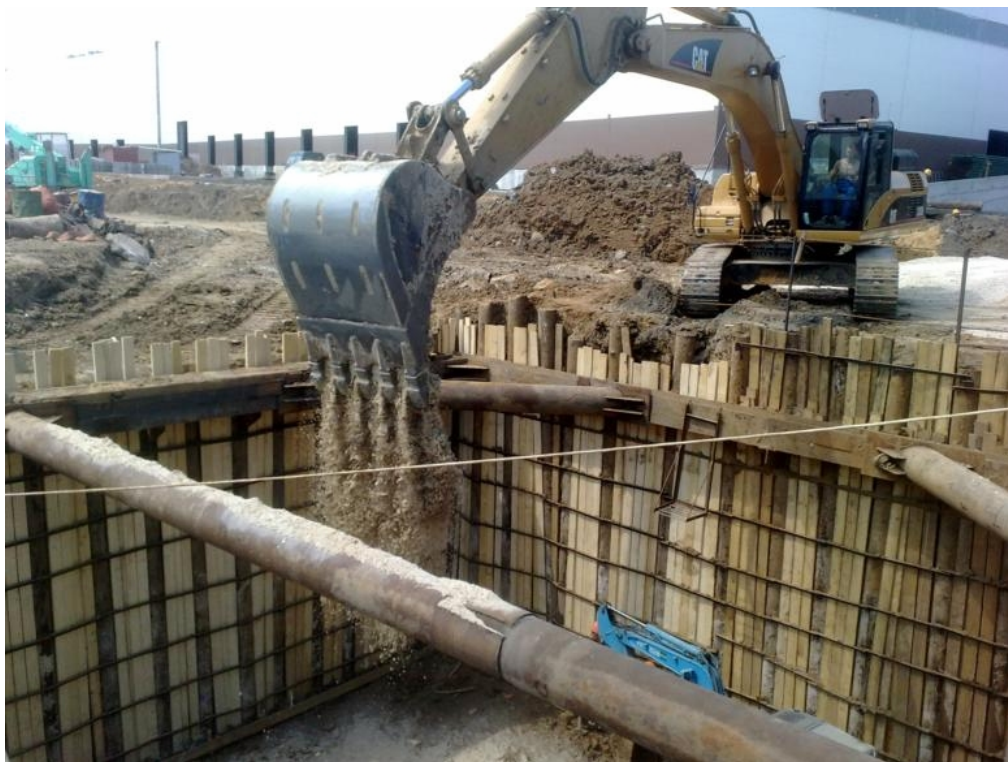
Рис.1.1.2. Крепление металлическими сваями
