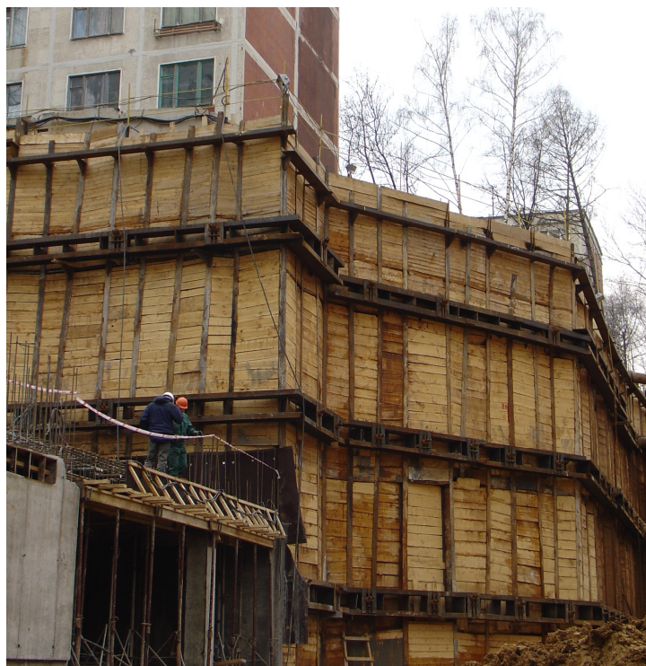
Рис. 1.3.2. Крепление бортов котлована анкерами-РИТ
