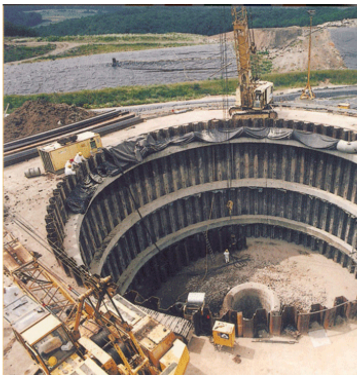
Рис.1.1.4. Шпунтовое ограждение котлована
