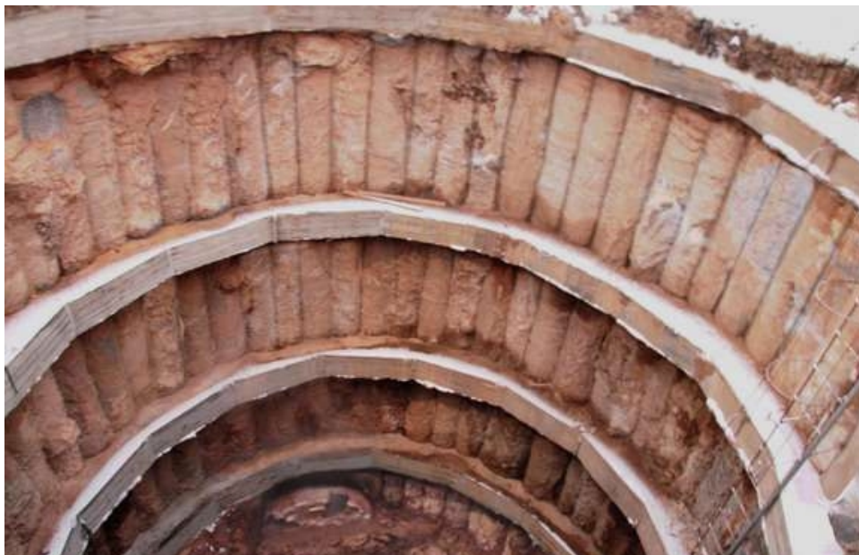
Рис.1.1.1. Крепление буросекущими сваями
