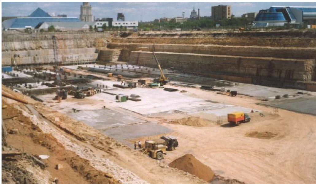
Рис. 5. Котлован Центрального ядра Международного центра «Москва-Сити» (1999)
