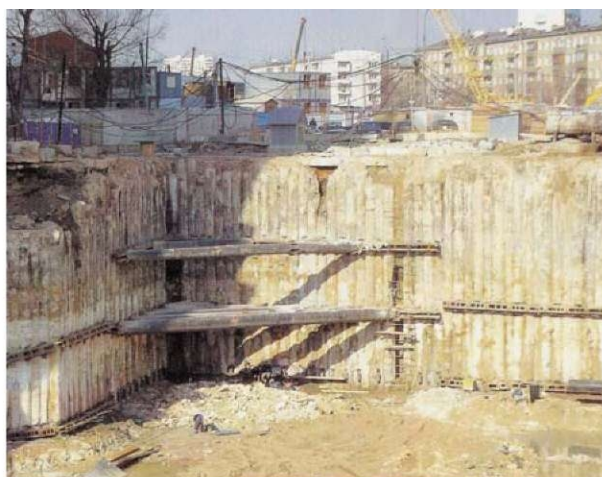
Рис. 12. Устройство ограждений из буровых свай.
