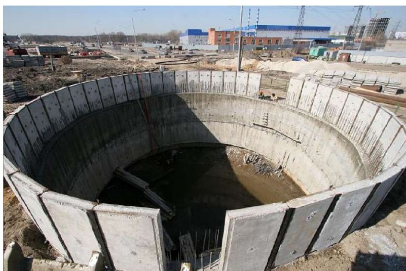
Рис. 8. Погружение сборно-монолитного опускного колодца.
