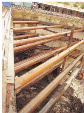
а) б) Рис. 17. Многоярусное распорное крепление котлована.
