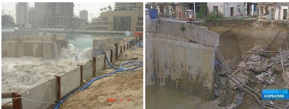
Рис. 1. Аварийные случаи обрушения котлована в Дубае и Хорватии
