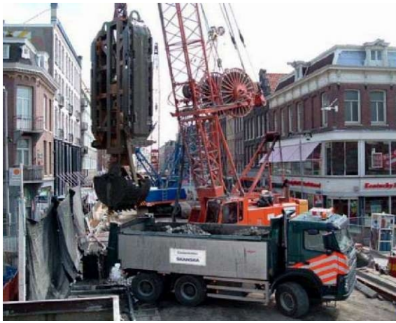
Рис. 11. Навесное оборудование для устройства «стены в грунте».
