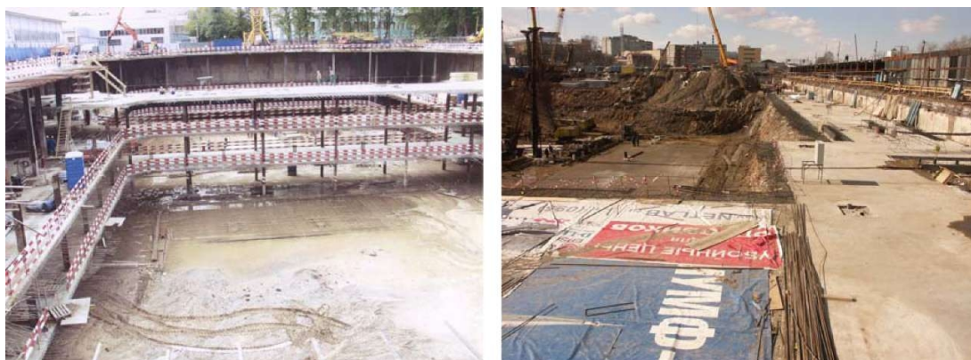
Рис. 23. Комбинированный способ строительства «semy-top-down».
