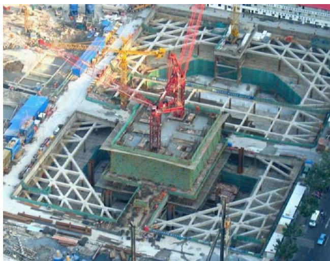
Рис. 19. Распорное крепление котлованов с помощью горизонтальных (а) и вертикальных (б) ферм.
